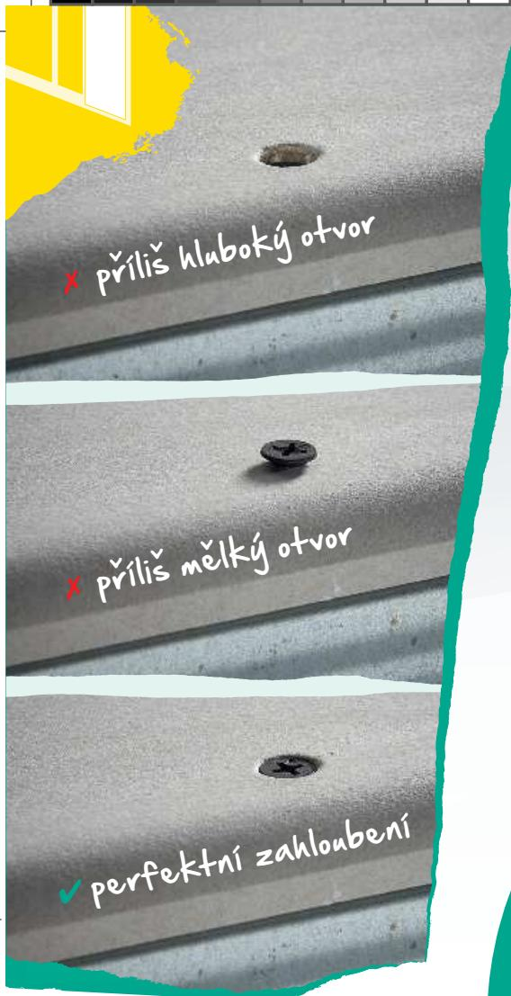
Hlavy šroubů by měly být mírně zapuštěné tak, aby je bylo později možné dobře přetmetlit. Pozor: nevrtejte příliš hluboko, jinak poškodíte kartonovou vrstvu a šroub už nebude dostatečně pevně držet. Chcete hrát na jistotu?
