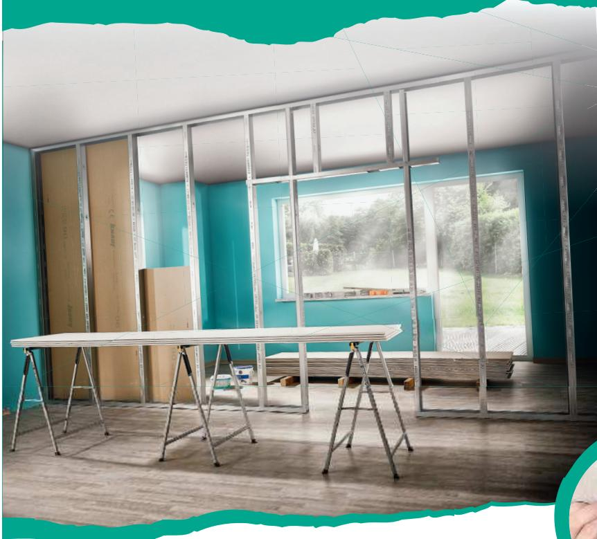
Sloupková konstrukce stojí, sádrokartonová deska je přiřznuta na správnou velikost – už brzy bude stěna vypadat tak, jak má. U desek přiléhajících ke stropu počítejte se spárou. Univerzální klínky značky **wolfcraft** jsou investicí, která se vyplatí a která se vám osvědčí v mnoha situacích.
