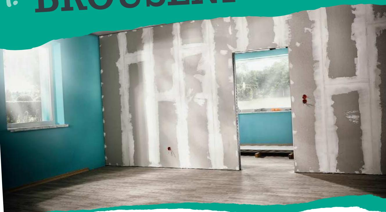
Nyní je větší část práce hotová a zbývá přejít k jemnému broušení. Zejména spáry mezi deskami potřebují k dosažení hladkého povrchu ještě jednou důkladně opracovat ruční bruskou. Je přitom důležité dbát na to, aby vrstva kartonu zůstala neporušená. Pro rychlejší průběh broušení a pro lepší stabilitu na stěně vyvinula společnost **wolfcraft** ergonomickou **kruhovou brusku** o průměru 225 mm.
